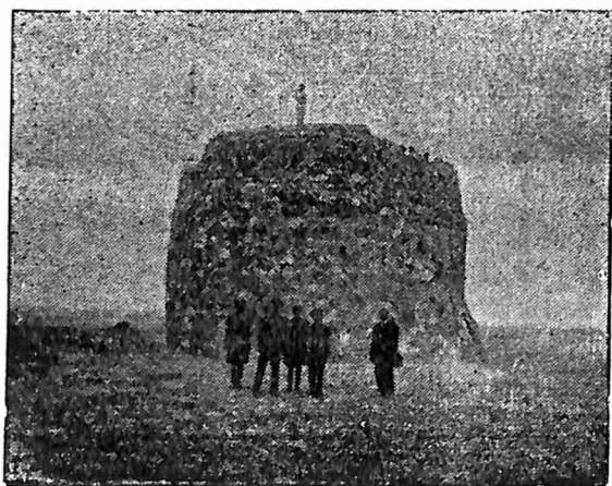
یکی از برجهای مراقبت پلدشت
